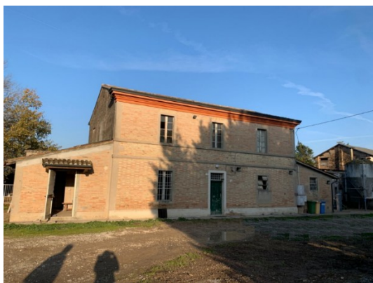
Stato di fatto esterno Fabbricato colonico
