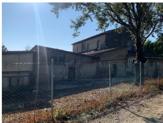
Stato di fatto esterno allevamento Capannone 1
