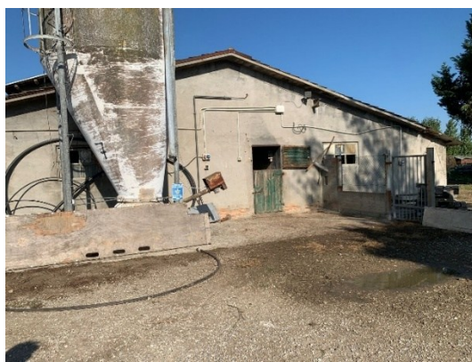
Stato di fatto esterno allevamento Capannone 1
