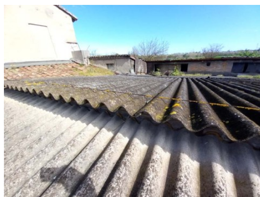
Stato di fatto copertura eternit Capannone 1
