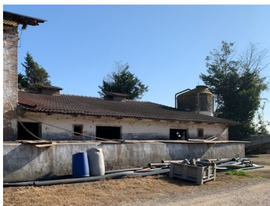
Stato di fatto esterno allevamento Capannone 1
